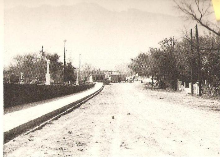
Salvo los arbotantes de piedra que nosotros colocamos a mediados de año, esta plaza carecía en lo absoluto de alumbrado y se hizo una excelente instalación de luz mercurial que consiste en diez arbotantes metálicos con 16 farolas; 12 de 250 watts y 4 de 400. La instalación es subterránea, empleándose los mejores materiales. Se enciende automáticamente con el moderno sistema de foto-celda.
