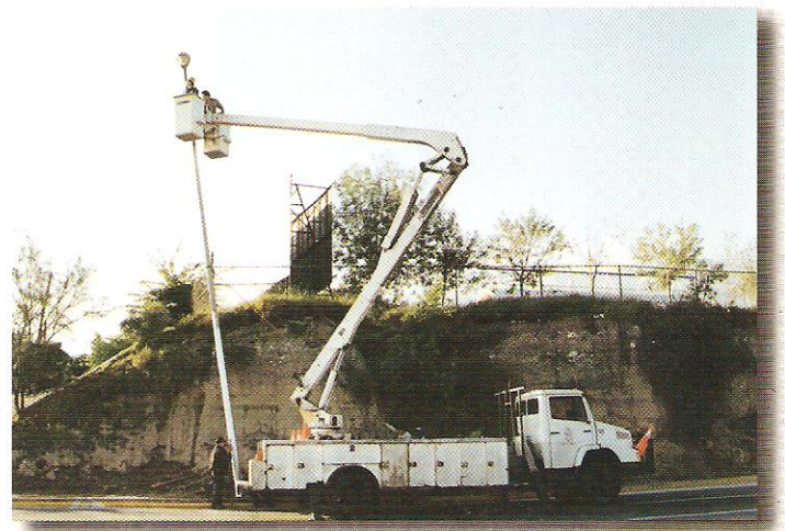
Las luminarias que conforman la red de alumbrado público son 12,610. La iluminación contribuye en forma muy importante a la seguridad.
