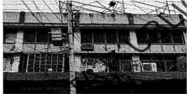
Figura 32 Edificación en Río Tamazunchale
