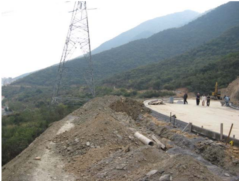
Fotografía 7.5.7.2.8e. Vista de talud.
