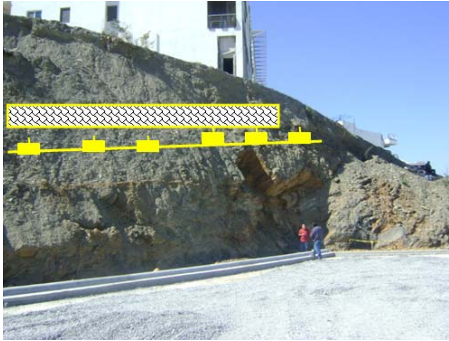
Fotografía 7.5.7.2.1.2. Línea de 6 anclas activas, sobre la cual se colocará una línea de gaviones para estabilizar el material suelto.
