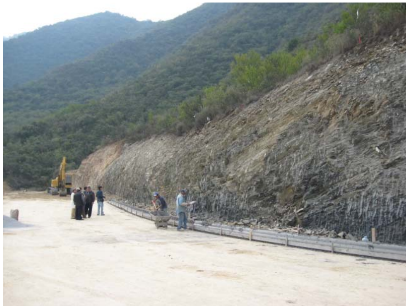
Fotografía 7.5.7.2.8d. Vista de talud.
