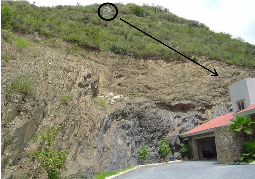
Fotografía 7.9. En la fotografía se observa en la parte superior la presencia de un bloque de 200 toneladas en riesgo de volcadura del bloque sobre la casa.
