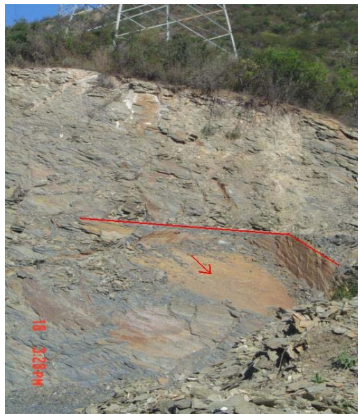
Fotografía 3.3.5a. Fallamiento planar en el Cerro del Mirador, fraccionamiento Bosques de San Agustín.
