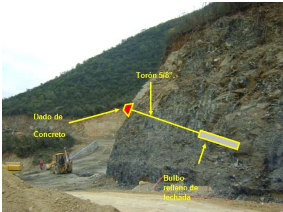
Fotografía 7.5.7.2.5.2a. Estabilización de talud mediante anclas.
