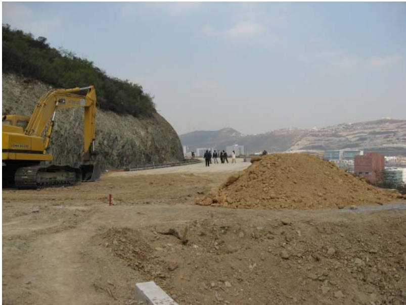
Fotografía 7.5.7.2.8f. Vista de talud.
