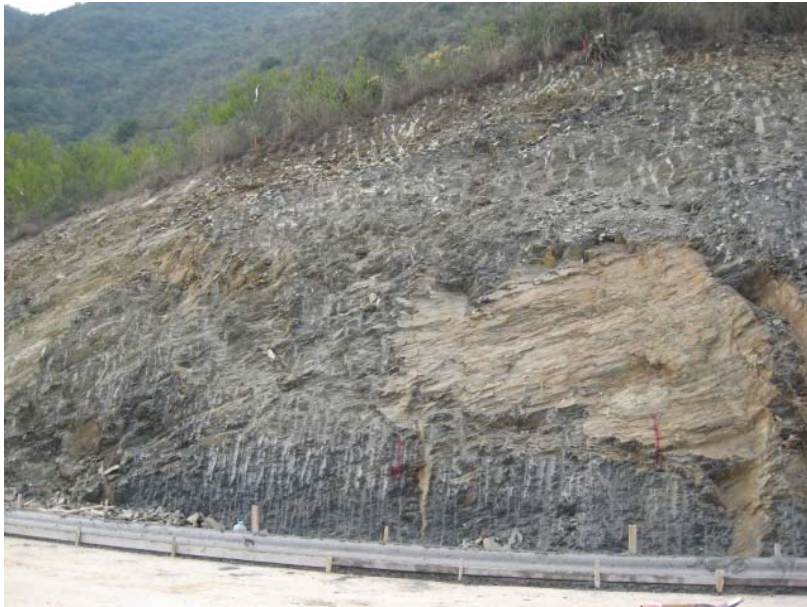
Fotografía 7.5.7.2.8c. Vista de talud.
