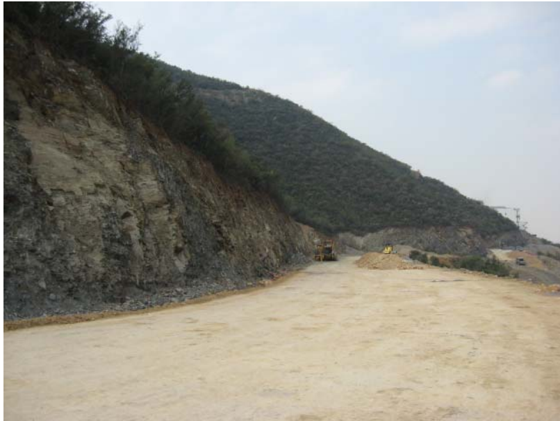
Fotografía 7.5.7.2.8a. Vista de talud.
