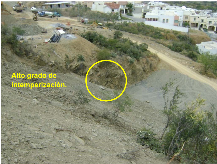
Fotografía 7.5.7.2.7. Talud existente frente a la iglesia. El afloramiento del estrato rocoso se hace visible en el corte.
