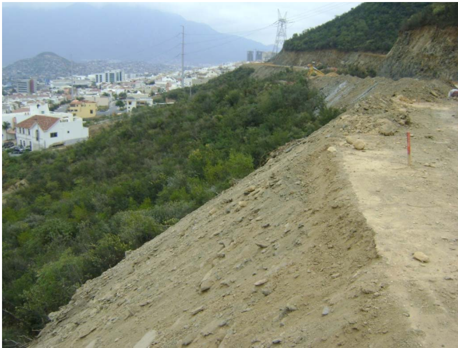
Fotografía 7.5.7.2.4. Talud en vialidad.
