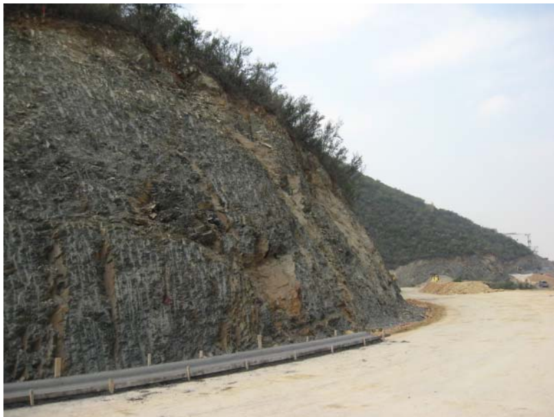
Fotografía 7.5.7.2.8b. Vista de talud.
