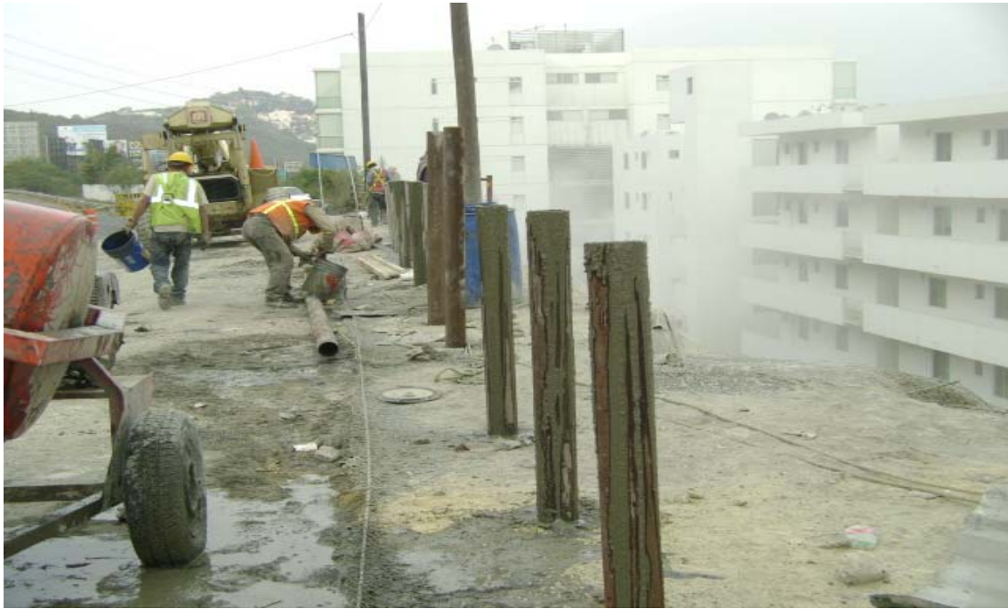
Figura 7.3a. Colocación de micro pilotes sobre la Avenida San Francisco.
