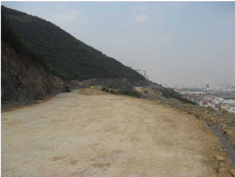
Fotografía 7.5.7.2.8. Vista de talud.
