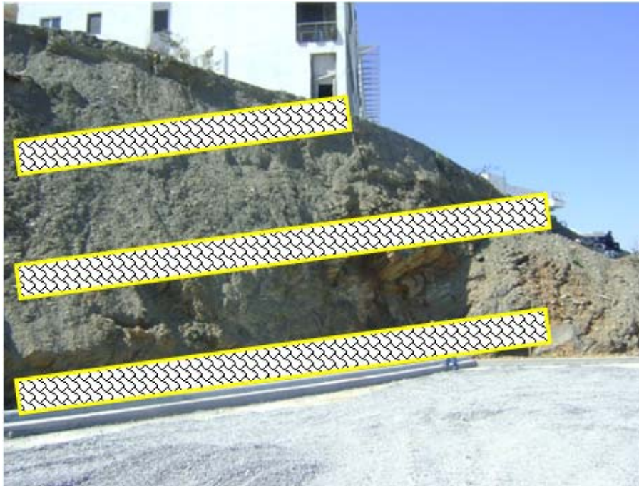
Fotografía 7.5.7.2.1.2a. Posición de las líneas de gaviones.
