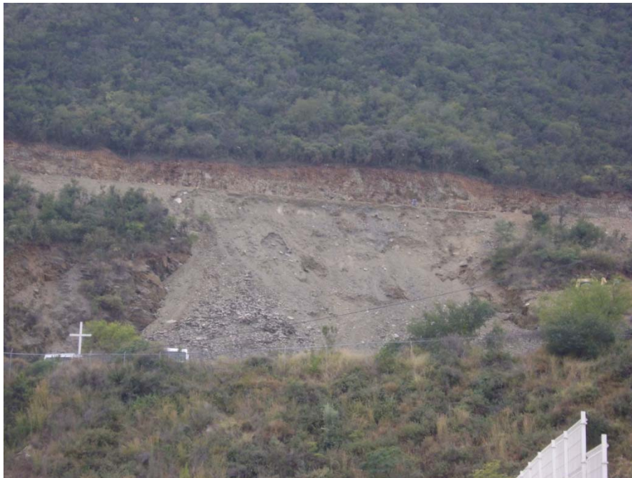
Fotografía 7.5.7.2.7.1a. La edificación de la iglesia se encuentra prácticamente en frente del corte del talud existente.
