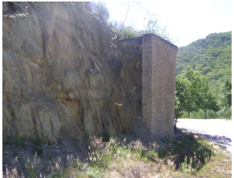
Figura 5.1.1c. Taludes afectados por fallas en el fraccionamiento Joya del Venado, San Pedro Garza García, N.L.
