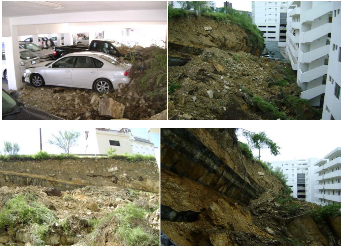
Fotografías 7.3. Daños por deslizamiento de talud en el edificio Santa Fe I.
