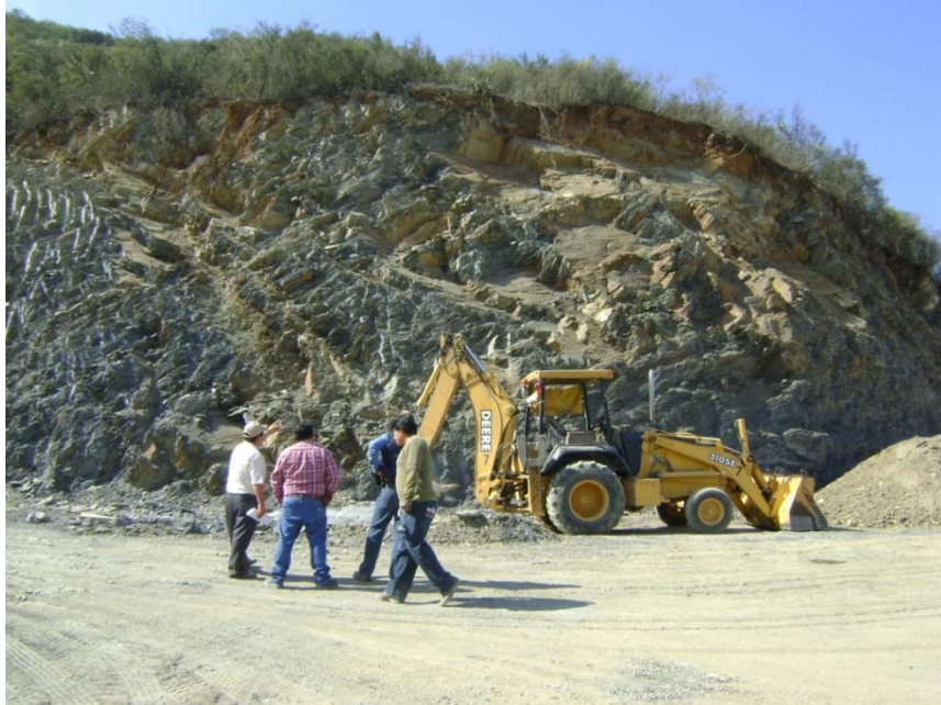
Fotografía 7.5.7.2.5. Talud en el fraccionamiento.
