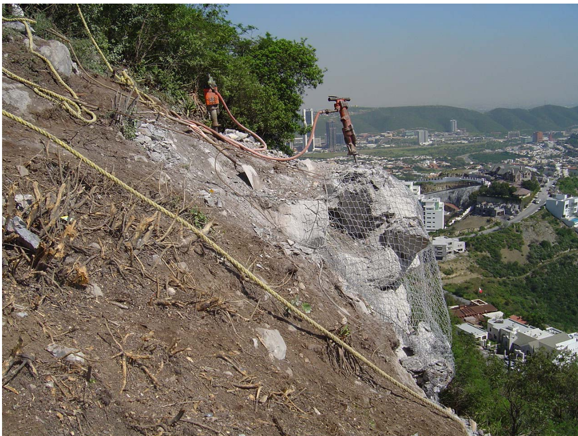
Fotografías 7.9a. 7.9b y 7.9c. Después de la demolición con martillo neumático y aplicación de productos químicos expansivos.
