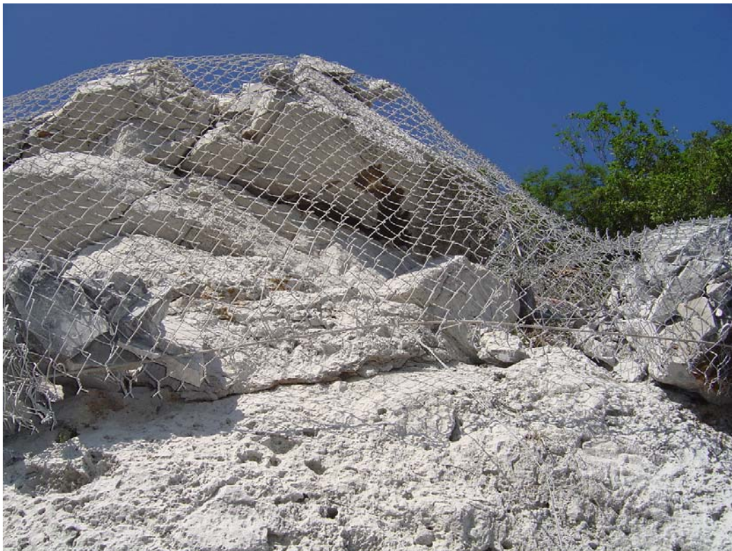
Fotografías 7.9d, 7.9e y 7.9f. Arrope de bloque mediante malla triple torsión sujeta con escarpas de acero de 2 pies de longitud con diámetro de 11". Sujeta con cable de acero de 1/4"
