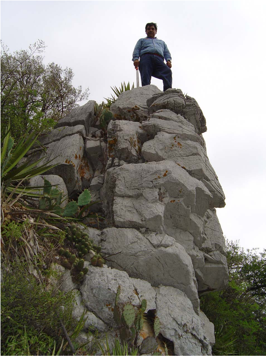
Fotografía 7.9.a. Bloque con fracturamiento intenso, con alto riesgo de deslizarse.
