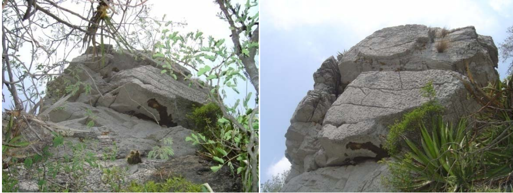
ANTES DE LA DEMOLICIÓN DEL BLOQUE VISTO DE ORTO ÁNGULO
