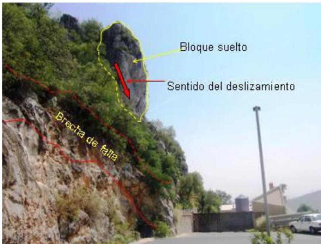
Figura 4: Bloque en peligro de deslizamiento
