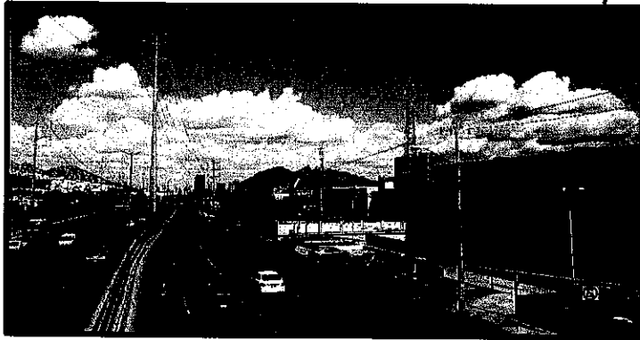
Fotografía No.16 Con vista hacia el oriente de Boulevard Gustavo Díaz Ordaz en donde se puede apreciar el sentido que tomarán los escurrimientos superficiales de eventos extraordinarios sobre la vialidad.
