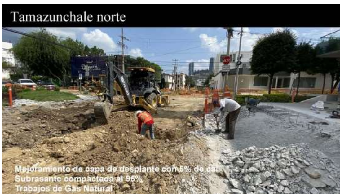
Mejoramiento de capa de desplante con 5% de cal Subrasante compactada al 95%
