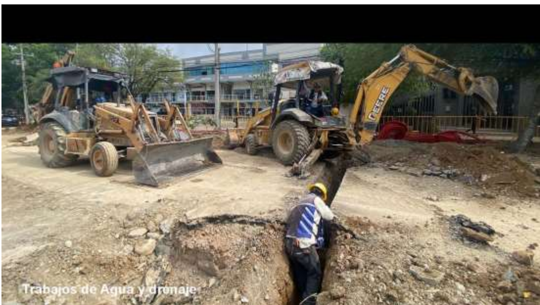
Trabajos de Agua y drenaje Renovación de registros de Monitoreo (grasas/químicos/etc.) Registros CFE / Telecomunicaciones
