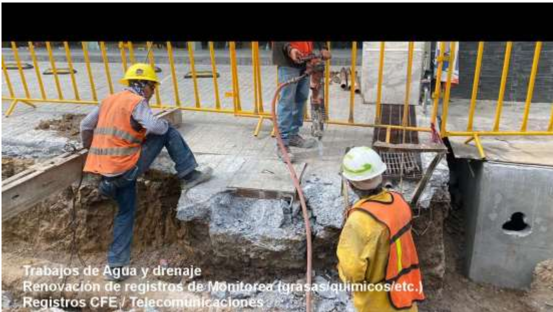
Trabajos de Agua y drenaje
