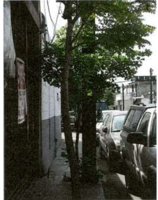
Figura 48 Situación de las aceras - Intervenciones incompletas y discontinuidad de material
